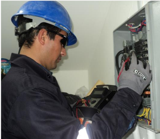
Mantenimiento de Sistemas eléctricos
